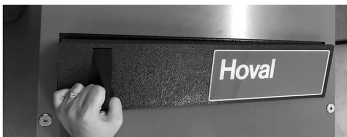
3. Retirer le support de filtre en le tournant de 90° (s'il y en a un).
