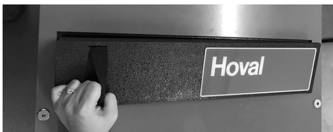
3. Retirer le support de filtre en le tournant de 90° (s'il y en a un).
