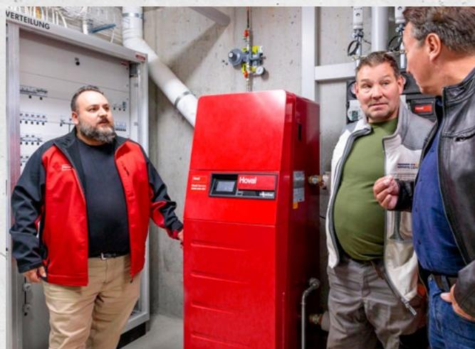
Une chaudière à condensation à gaz UltraGas® 50 associée à un réchauffeur ESSR 100 chauffe la surface d'habitation de 1500 m<sup>2</sup>.
