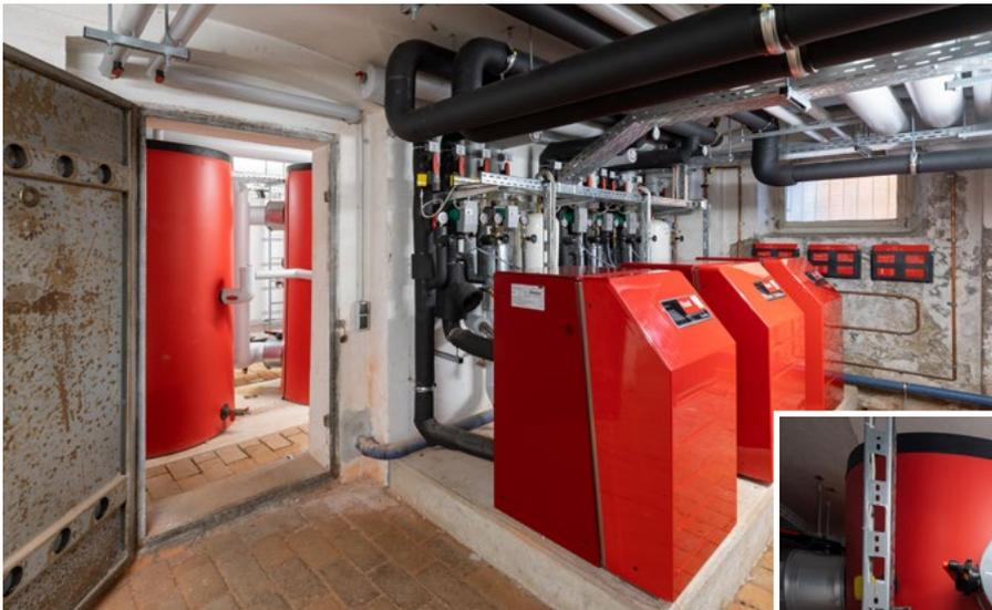
La nouvelle centrale de chauffage est constituée d'une chaudière à condensation à gaz UltraGas®, de trois pompes à chaleur Thermalia® et d'une centrale de cogénération (CHP).
