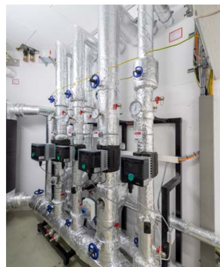
Le distributeur de chaleur et de froid TransShare veille à une distribution efficace de l'énergie.
