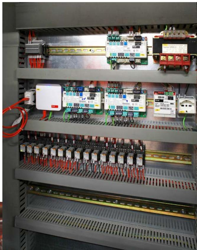
I componenti del sistema di regolazione si trovano in un quadro elettrico. TransTherm® aqua F produce l'acqua calda per il Seminario.
