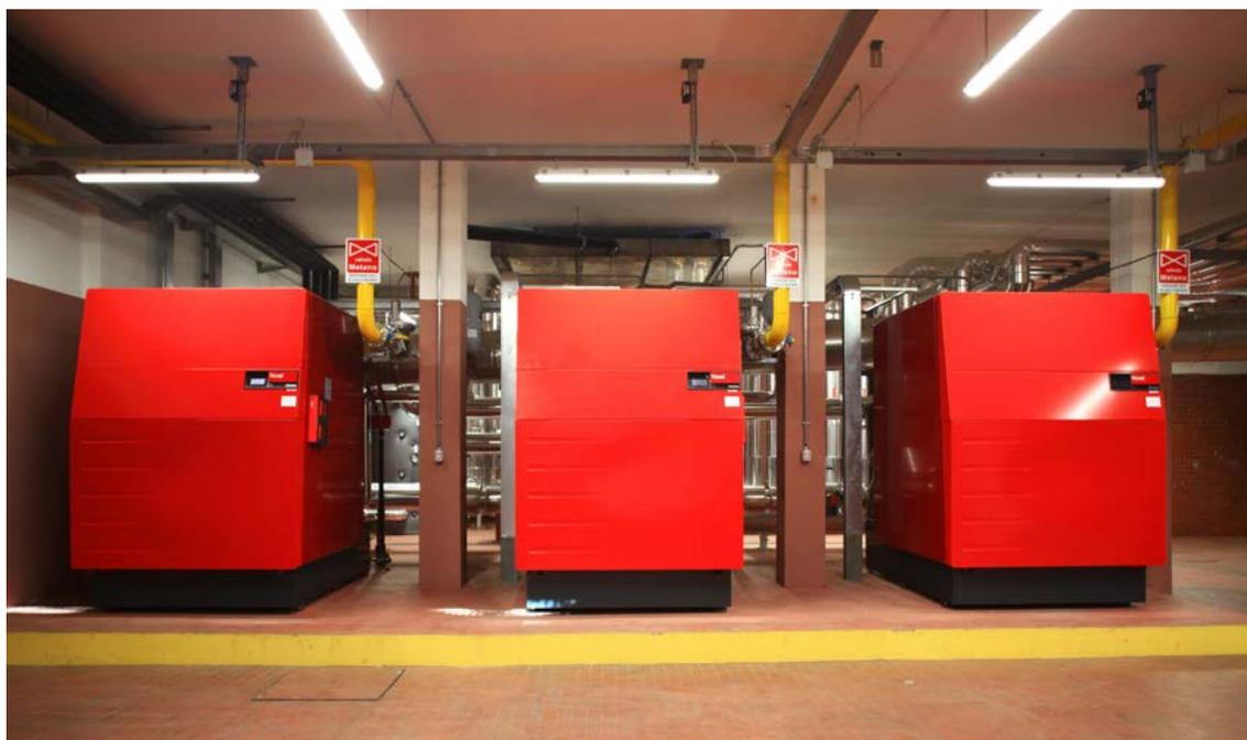
Tre caldaie a condensazione UltraGas® forniscono il calore necessario alla rete locale per il riscaldamento e l'acqua calda.
