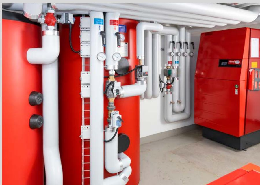
La combinazione di due pompe di calore aria/acqua UltraSource®, una caldaia a condensazione a gasolio UltraOil, l'accumulo di acqua potabile CombiVal CR 800 e un accumulo di energia EnerVal 800 ha dato vita a una soluzione ibrida perfetta.
