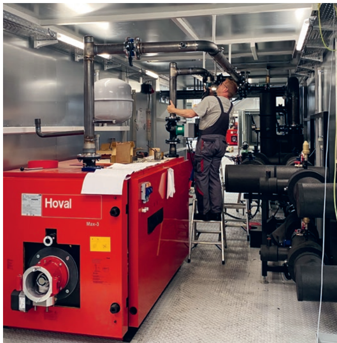
Travaux de montage sur une centrale énergétique
