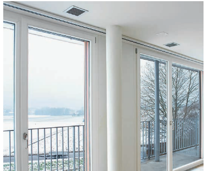
Wohnraum mit Raumsteuergerät und Zuluftauslässen in der Decke oberhalb der Fenster.
