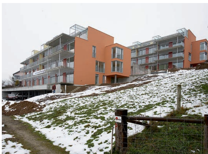
Gesamtansicht der Überbauung
